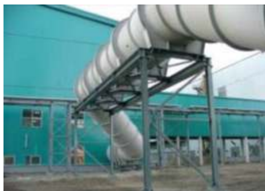
г. Саяногорск. Воздуховоды и газоходы. Хакасский алюминиевый комбинат. Защита от конденсата, ржавчины и потерь тепла.
