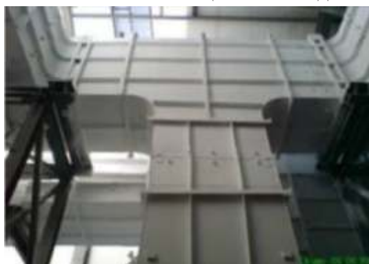
Воздуховоды. Нет ржавчины, исчез конденсат. Резко снизились потери тепла.
