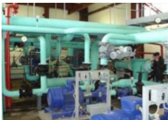
TLM Ceramic исключает конденсатообразование на трубах холодной воды. Наносится на работающее оборудование до температуры +170 °С.
