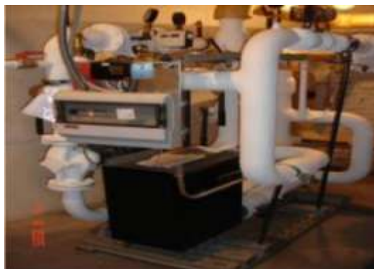
TLM Ceramic дает возможность визуального контроля и быстрого доступа к запорной арматуре.
