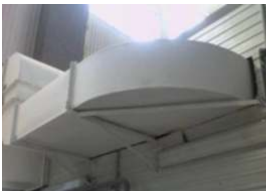
г. Казань. ТЭЦ-1, воздухопроводы. Защита от конденсата, ржавчины и потерь тепла.
