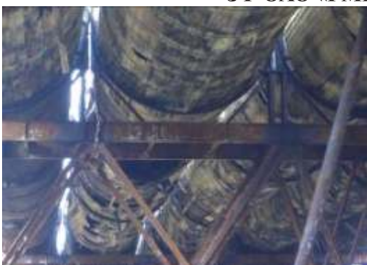
Промерзшая старая изоляция. Превращается в радиатор при порывистом ветре резко отдает тепло.
