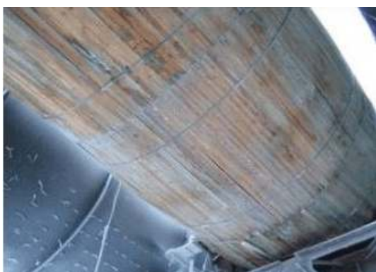
Замена старой изоляции воздухопроводов и газоходов на ЗФ ОАО «ГМК «Норильский никель».
