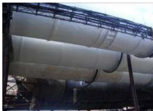
Замена старой изоляции воздухопроводов и газоходов на ЗФ ОАО «ГМК «Норильский никель».
