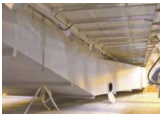
г. Саяногорск. Воздуховоды и газоходы. Хакасский алюминиевый комбинат. Защита от конденсата, ржавчины и потерь тепла.
