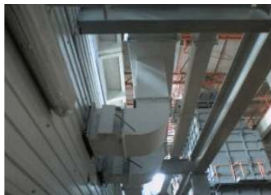
г. Казань. ТЭЦ-1, воздухопроводы. Защита от конденсата, ржавчины и потерь тепла.
