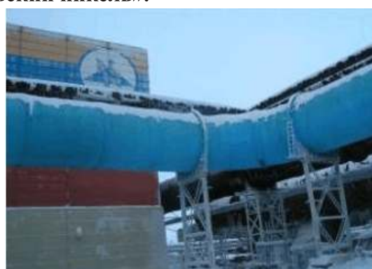
Снег лежит, не тает. Изоляция надежно сохраняет тепло и при сильных ветрах.
