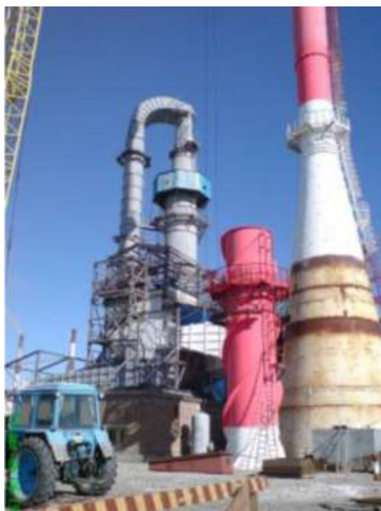
г. Саяногорск. Хакасский алюминиевый комбинат. Труба и оборудование газоочистки. Защита от коррозии и потерь тепла.
